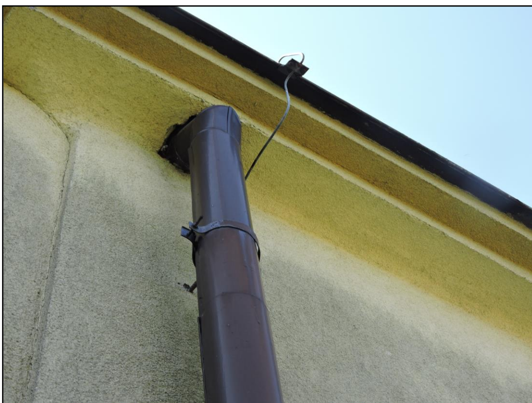
Fot.3 Lustracja szczeliny pomiędzy rurą spustową rynny a stropodachem. jednej z części elewacji oznaczonej symbolem literowym „F”
